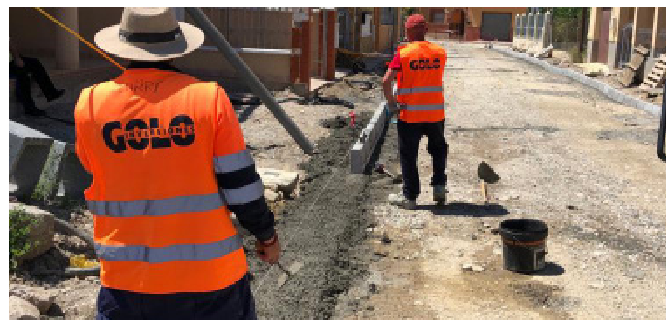
Los trabajos en la calle Fuente Álamo del Barrio Bravo.
