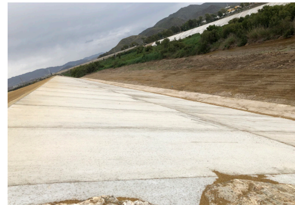
Desembocadura del río Almanzora tras las obras.
